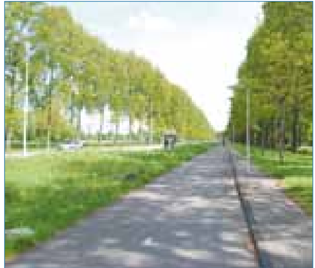
vrijliggend fietspad Wassenaarseweg
