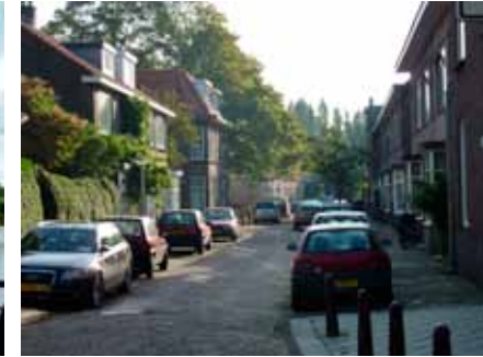
3. Oosterstraat (foto) en Waardstraat
