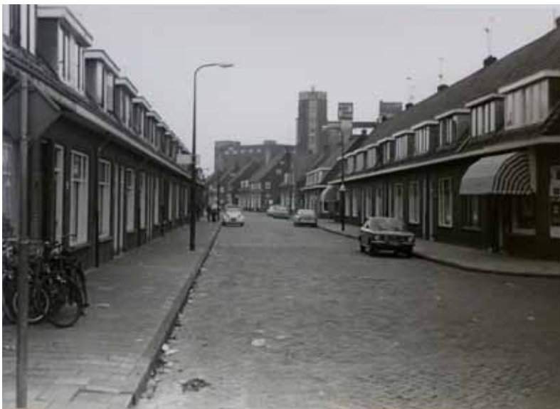
Trompstraat gezien vanuit de Heemskerkstraat, 1977. Op de achtergrond zijn bouwphase II van Eensgezindheid en de meelfabriek te zien. Op de voorgrond de woningen horend bij het uitbreidingsplan van 1933. Rechts op de hoek een winkelwoning aan het plantsoenje bij de Heemskerkstraat Foto: J.W.C. Postel. [RAL]
