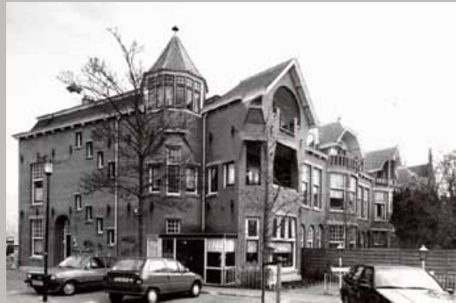
Woningbouwcomplex Rijnsburgerweg-Mariënpoolstraat te Leiden door H.J. Jesse en W. Fontein, 1907. [Bonas]
